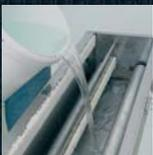
**2/** Wasser auf das Gewebe auftragen – ganz einfach mit dem Wasserauftragsgerät. Bahnen falten und 2 bis 10 Minuten ruhen lassen, damit das Wasser den Spezialkleber optimal aktiviert.
