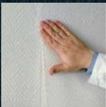
**3/** Das Gewebe an der Wand verkleben, bei Bedarf problemlos verschieben und in die optimale Position bringen. Trocknen lassen: Nach etwa 20 Minuten verbinden sich Gewebe und Wand, in nur 7 bis 12 Stunden trocknen die Bahnen vollständig ab.
