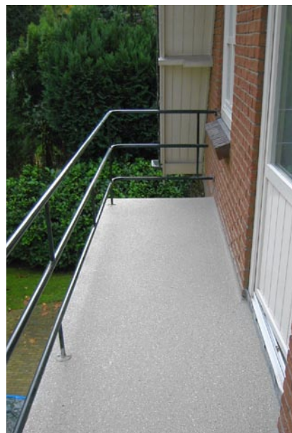
Een balkon in Apeldoorn nadat het is bewerkt met het systeem.
