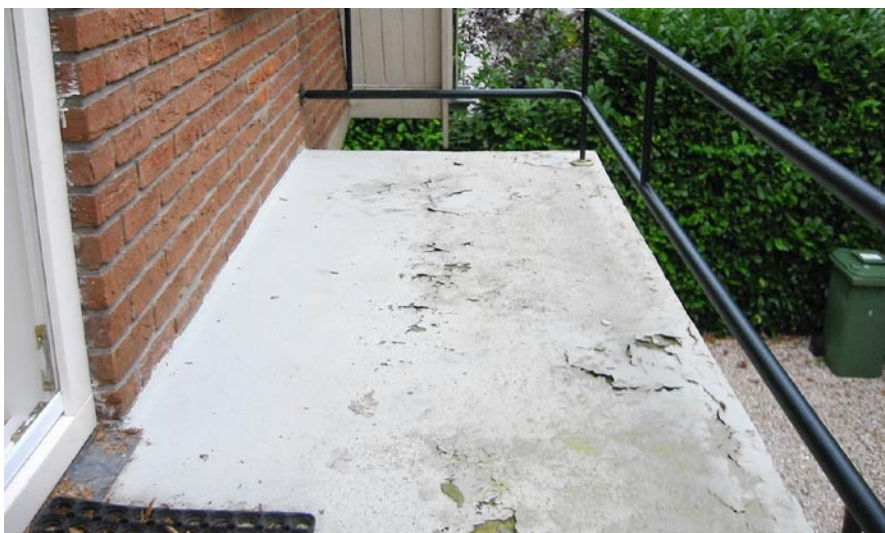
Hetzelfde balkon als op de foto op pagina 10, maar nu voordat het is bewerkt met het Vulkem Quick Balcony Systeem.
